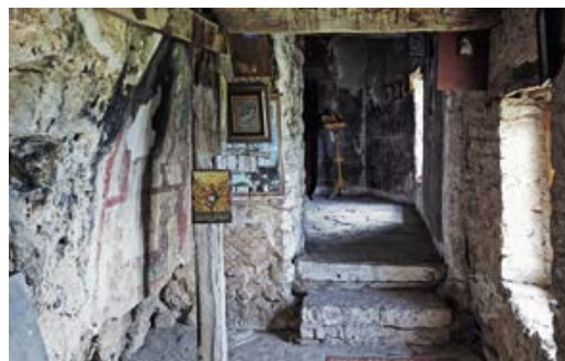
Vstup do kostelíku, 2023.
