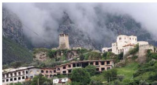
Pohled na rozestavěný komplex pod pevností, 2016. Obrázek nahoře je z roku 2022, kdy už byl komplex hotový.
