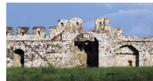
Pevnost s kulatými obrannými věžemi má 3 vchody, měří 90 × 60 m a hradby jsou vysoké až devět metrů, 2023.
