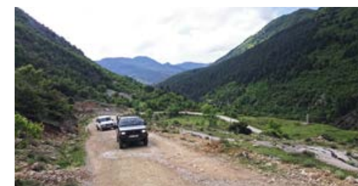
Výjezd od Vjosë k Leskoviku vede po poměrně rozbité silnici, 2016.
